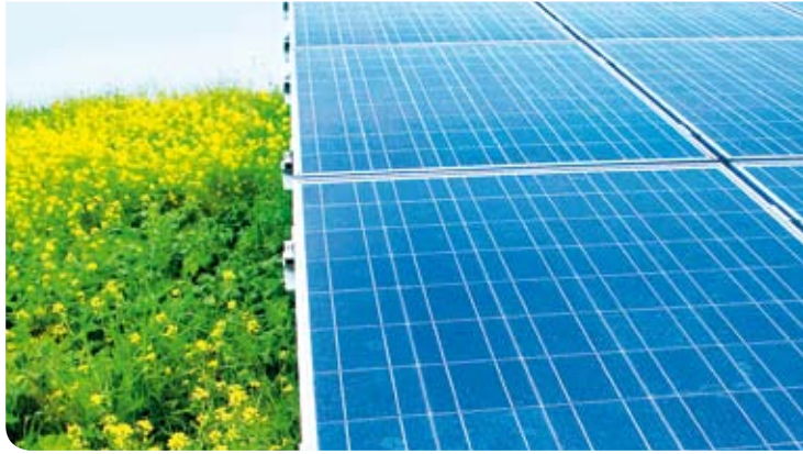
Solarfeld im Solar Valley
